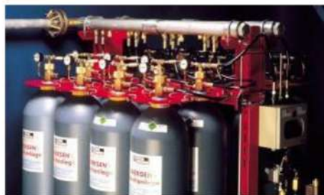
ΣΧΗΜΑ Πυροσβεστικό συγκρότημα με κατασβεστικό αέριο INERGEN
