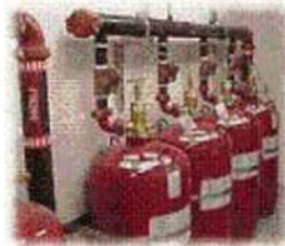
ΣΧΗΜΑ Πυροσβεστικό συγκρότημα με κατασβεστικό αέριο FM 200
